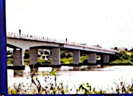
Cầu Tuyên Sơn - Đà Nẵng (2001) Toàn bộ sàn cầu/thân trụ/dài cọc được xử lý chống thấm & bảo vệ bởi Radcon #7.
