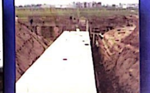
21 HẦM DÀN SINH VỐ3 - HÀ NỘI R #7 xử lý mái - tường hầm trước khi lấp đất, cho hệ thống 21 hầm/hào Tuynel.
