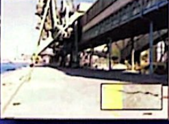
Cảng Kembla, Wollongong, Úc Radcon #7 chống thấm toàn bộ, hàn gắn hệ thống các vết nứt tới 2mm.
