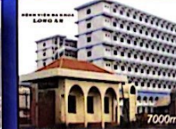
BỆNH VIỆN LONG AN R #7 xử lý sàn mái, khu WC, bể nước, mái dón, đường nứt, hồ thang máy.
