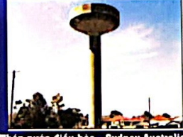
Tháp nước điều hòa - Sydney Australia 1.000 m 2 . Radcon #7 chống thấm mặt trong của bể tháp, trước đây bị thấm nước nặng.
